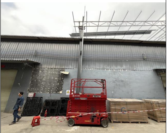
图 6：施工单位用液压升降平台运送人员和材料到屋顶
